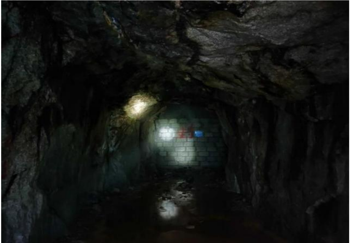
图 2-2 +190m 中段部分采空区封闭治理现状
